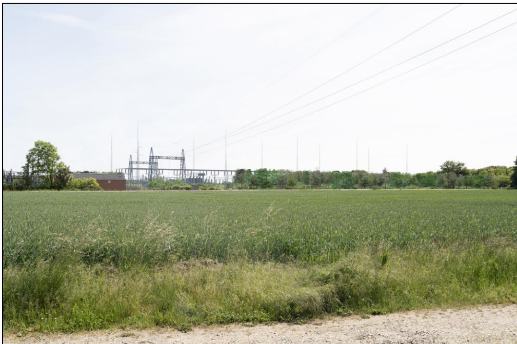
Figur 2-7: Visualiseret fremtid efter 10 år, hvor beplantningsbæltet er etableret samt hvor anlægget er udbygget med yderligere fire lynfangstmaster (jævnført afsnit 2.1.3 og Figur 2-8). Kilde: Energinets visualiseringer.
